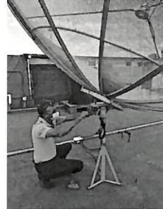
Ajuste de tornillería a antena receptora.
