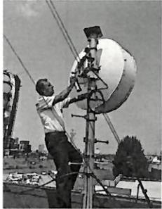
Aplicación de líquido anticorrosivo a tornillería.
