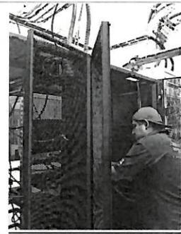
Se realiza inspección de conectores en equipos periféricos de cuarto de transmisión.
